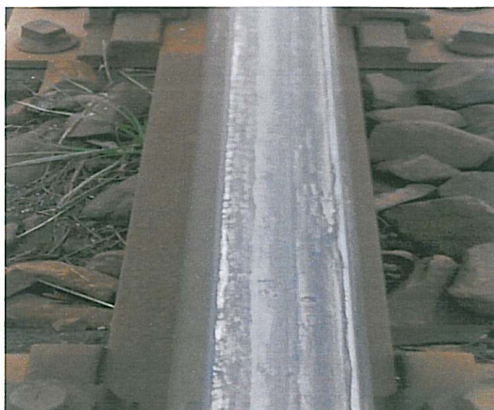
Rys. 23. Widok ogólny szyny z naniesioną warstwą smaru po hamowaniu.
